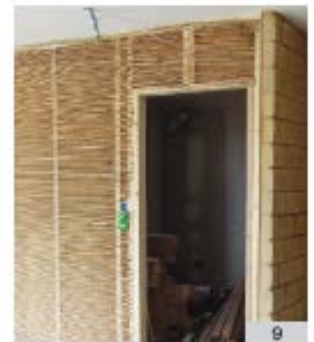
Cloison bois, canisse et terre
