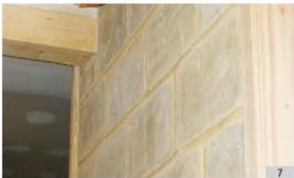
Mur en briques de terre crue
